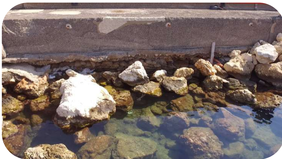
Figura 3 – precedente ciecatura eseguita con sacchi di argilla (rilievo con drone)
