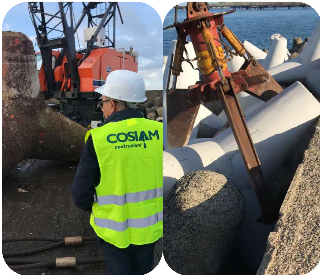
Figura 6 e 7 – a sx tetrapodo integro salpato in coperta prima di essere riposizionato, a dx tetrapodo posizionato con benna idraul.
