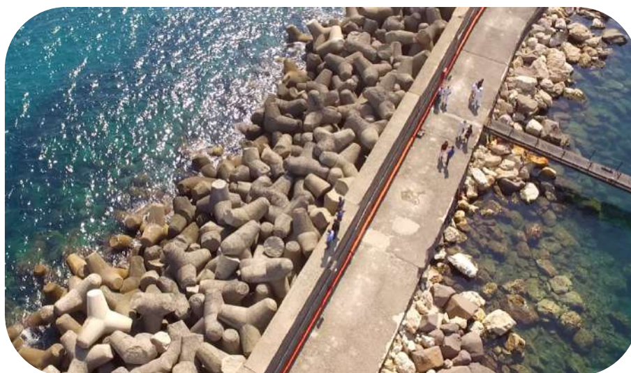
Figura 2 – stato di fatto pre-lavori (rilievo con drone)
